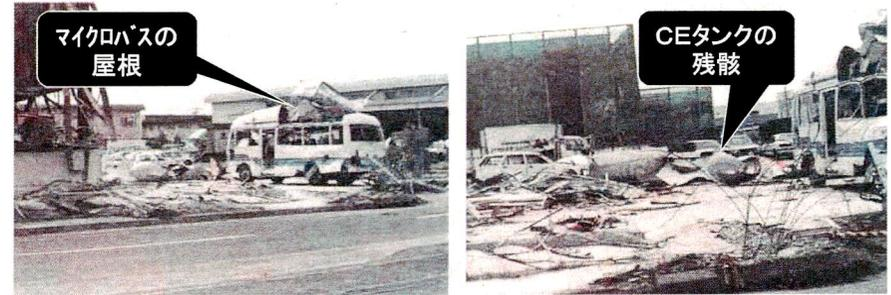
破壊時推定内圧 **70気圧** マイクロバスの屋根がめくれ上がっていることからその破壊力が想像できる
